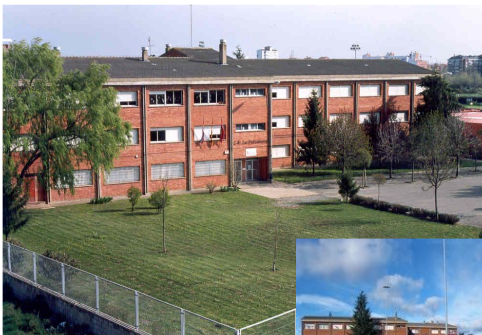
EDIFICIO DE PRIMARIA
