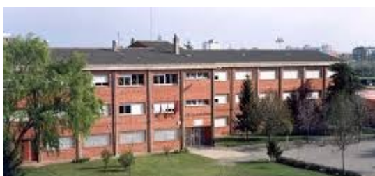
Edificio de Primaria
