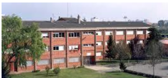
Edificio de Primaria
